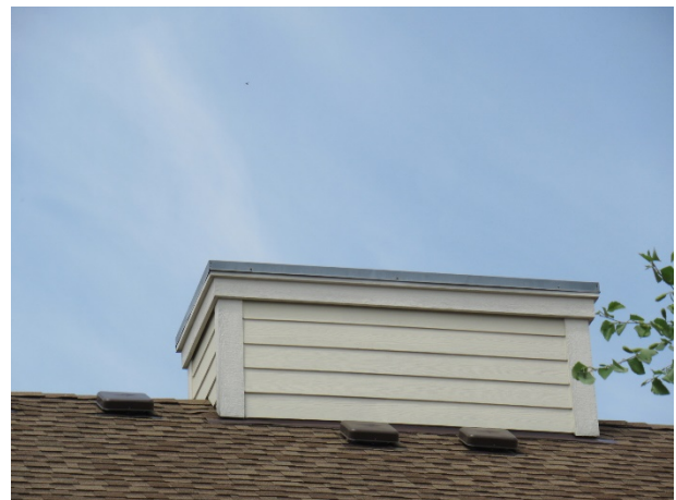
Chimney cap overview
